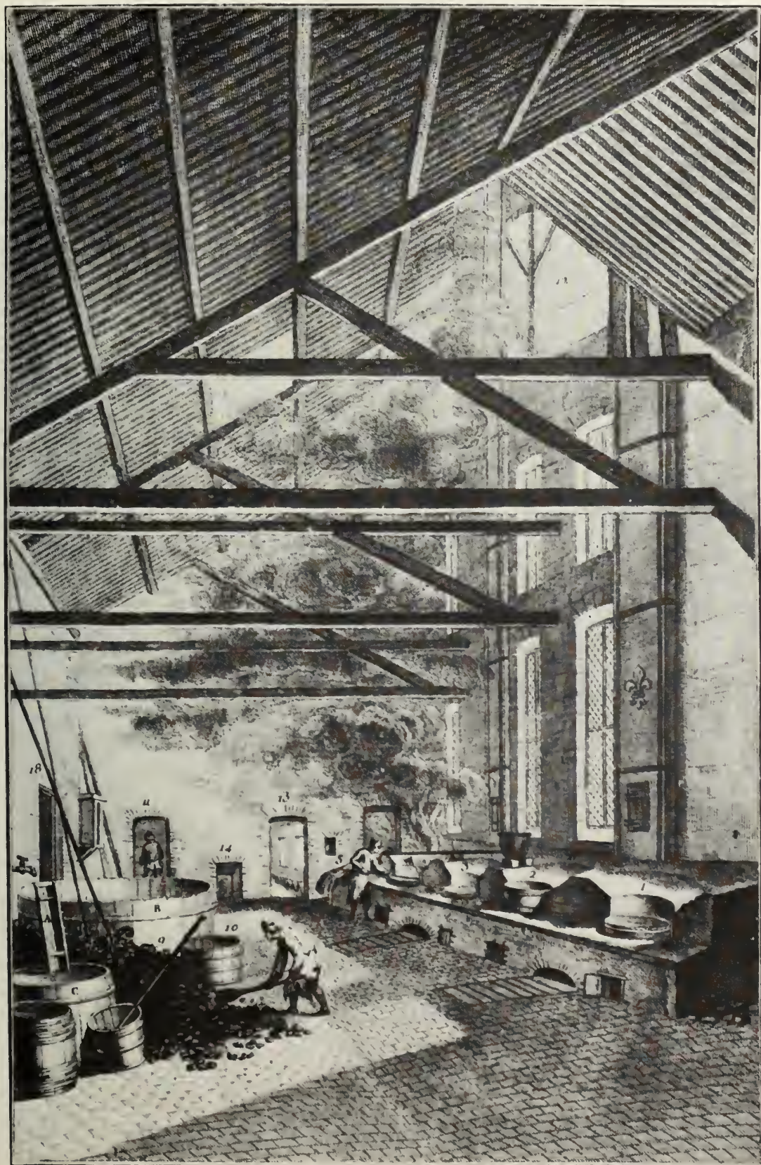
Chaudières dans une sucrerie
